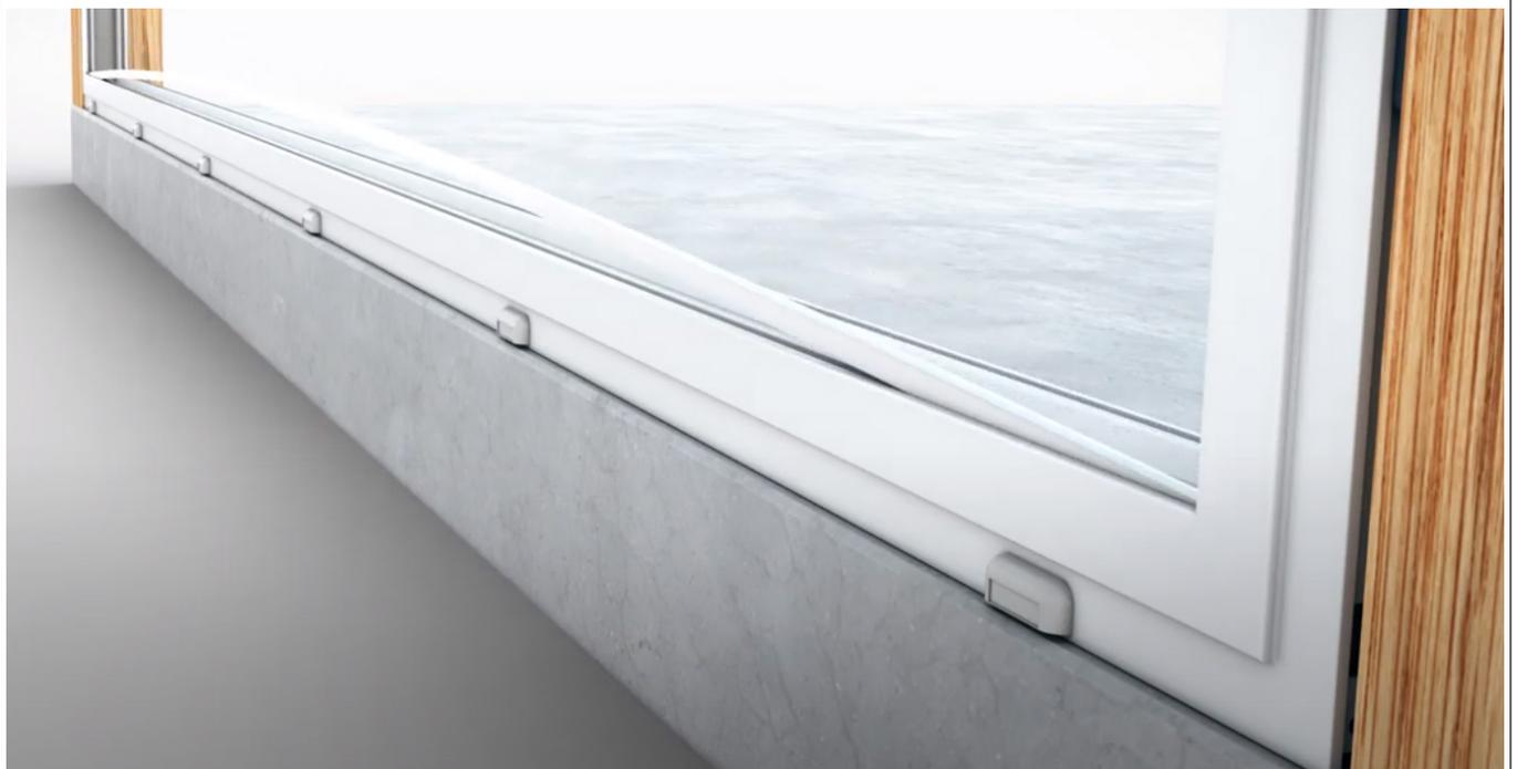
**12.2** Bringen Sie zuerst die Kunststoffleiste unter der Endplatte an. Der Abstand zwischen der Abdeckleiste und der Endplatte sollte ca. 35 mm betragen.
